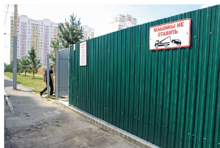
В «Губернском» продолжается реконструкция площадок для сбора бытовых отходов. Две из них (по улице Земская, 2 и между домами №№ 6 и 13) обустроены по просьбе жильцов.
